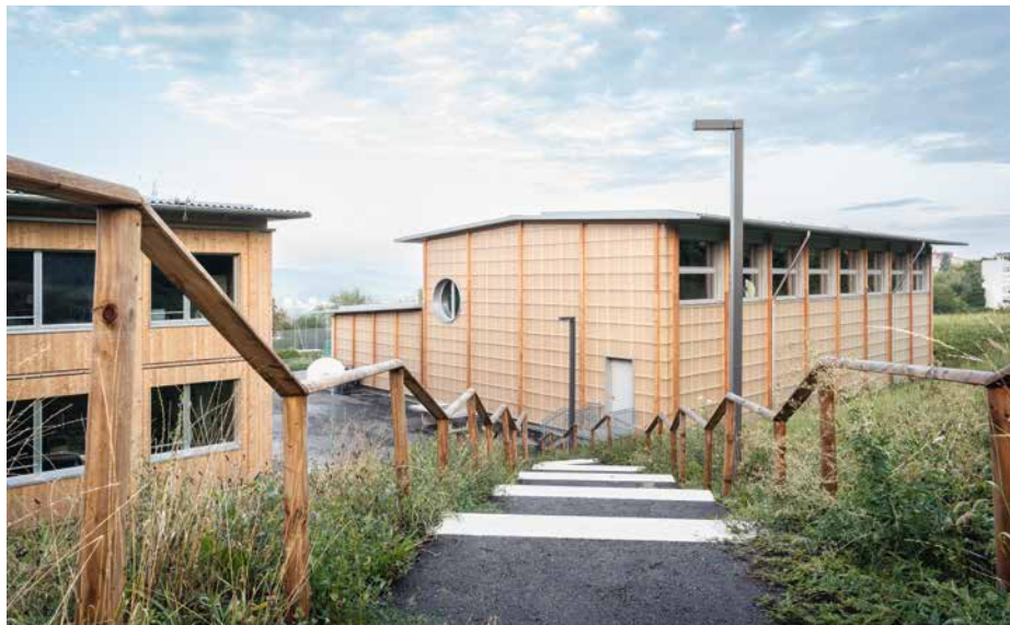
Die wiederverwendbaren Turnhallen sind flexibel konstruiert und können innerhalb von nur vier Arbeitstagen aufgebaut werden
