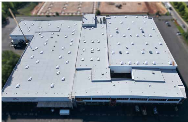
Großzügige Dachflächen durch die Niederlassung Hanau – der Standort der Immobilie ist in Nordhessen. Klar gegliedert, präzise umgesetzt und funktional in die Gesamtarchitektur eingebunden
